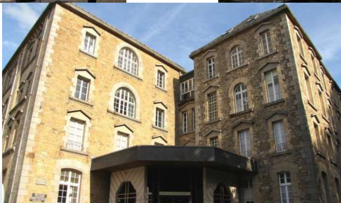
Entrée sud Niveau 0
